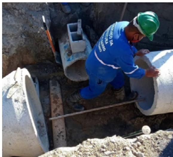
**Figura 1** – Interferência de rede de esgoto durante instalação de estrutura de drenagem
