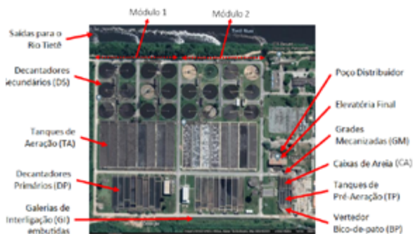
Figura 1 – Vista aérea da Estação de Tratamento de Esgoto Barueri.
