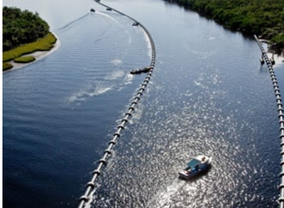
Transporte do 1º tramo do emissário de Praia Grande
