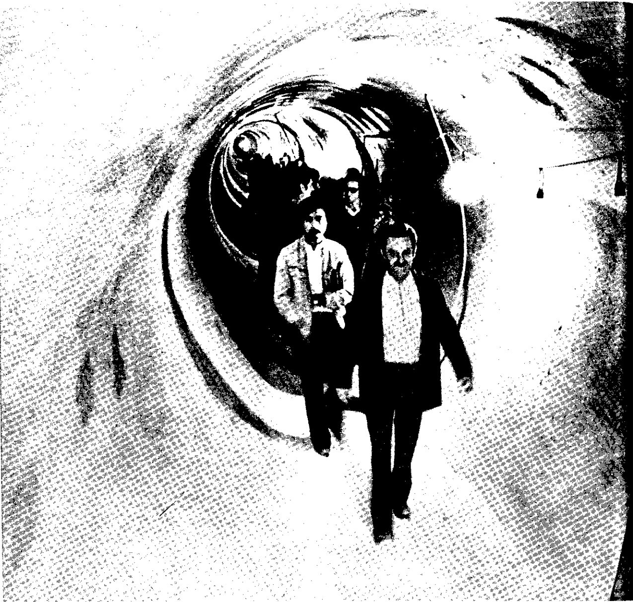
Fig. 14 B – Aspecto do acabamento interno – Secção circular concretada no local.
