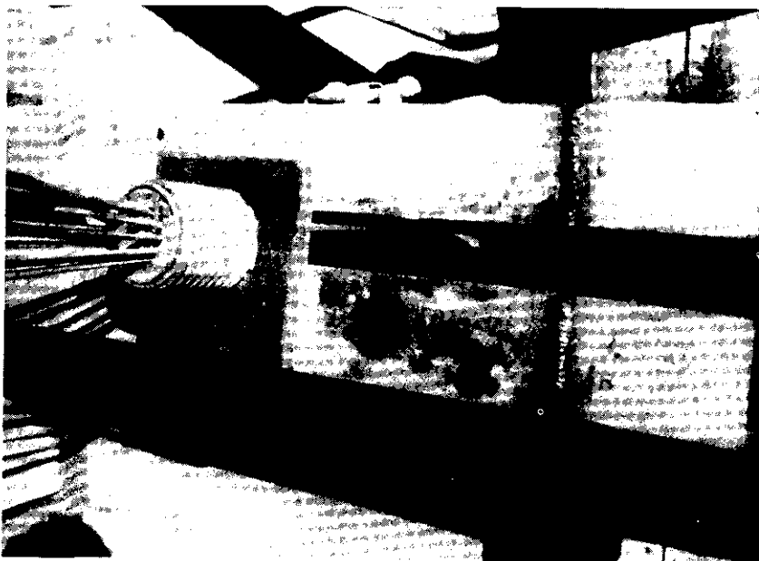
Foto 10 — Posicionamento da longarina e chapa dupla para proteção do cone de ancoragem.
