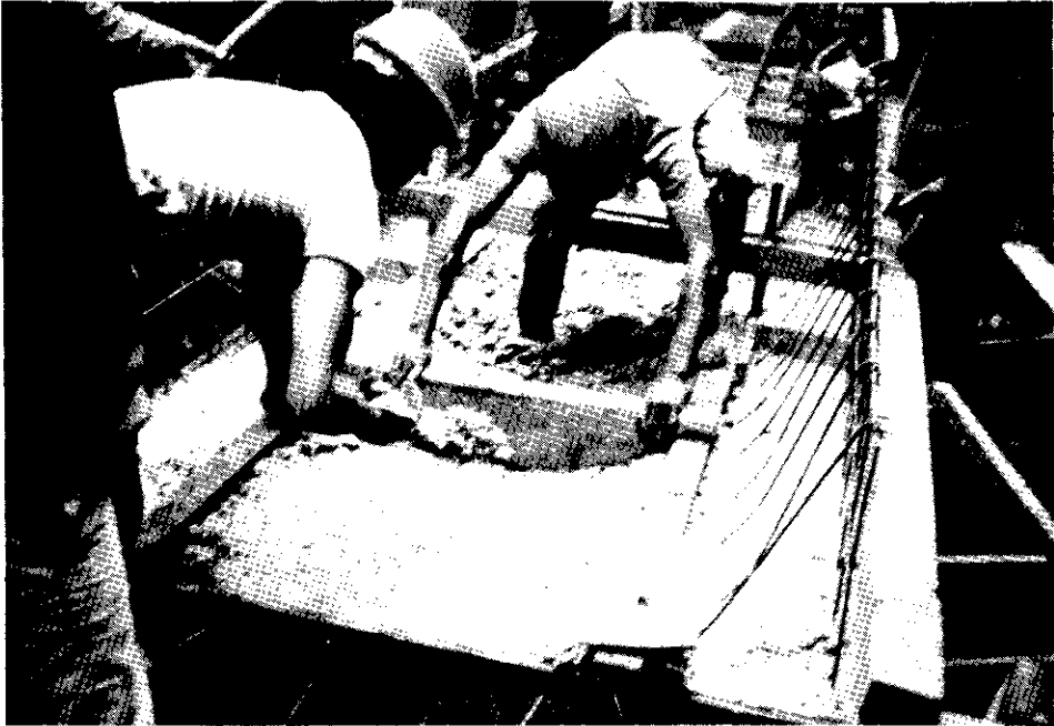
Foto 1 – Concretagem do Radier.
