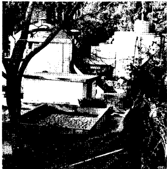
Foto 24 — Vista geral da ETE do Educandário D. Duarte, vendo-se ao fundo o tanque «Imhoff» e o filtro biológico. A frente, os leitos de secagem e a casa de bombas
