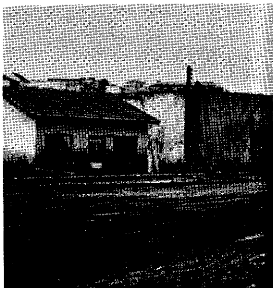
Foto 14 — Vista da casa de bombas e tanque «Imhoff» da ETE do Jardim Previdência
