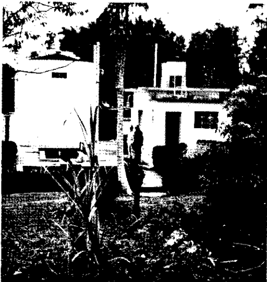
Foto 22 — Fotografia do almoxarifado e filtro biológico da ETE do Hospital do Jaçanã
