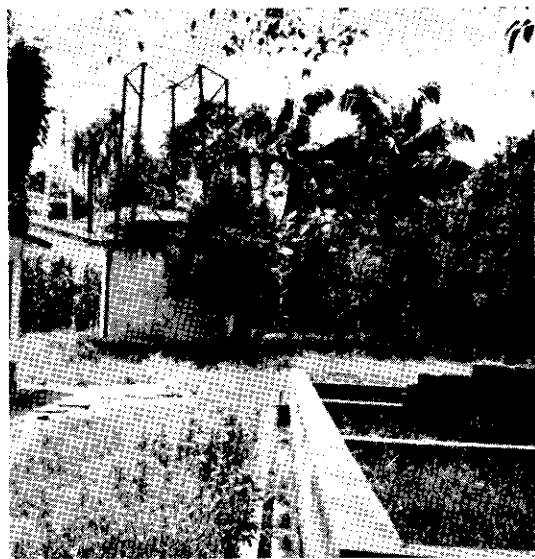
Foto 17 — Vista do gasômetro na ETE do Hospital do Mandaqui (em precário estado). Do lado direito, vista parcial dos leitos de secagem
