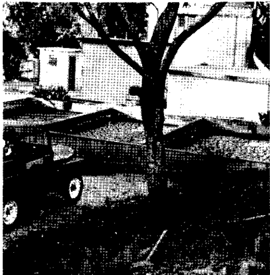
Foto 23 — Leitos de secagem dos lodos digeridos na ETE Educandário D. Duarte, na Estrada Velha de Cotia
