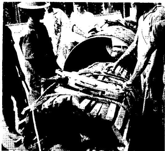
Foto 5 — Polly-Pig comprimido à entrada do tubo de aço
