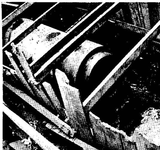
Foto 9 — Início da saída de água pelo tubo, indicando que o Pig estava nas proximidades (vala da Av. dos Bandeirantes)
