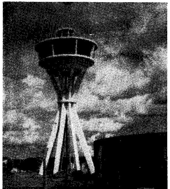
Fig. 8 — Torre padronizada no Município de Campinas, S. P.
