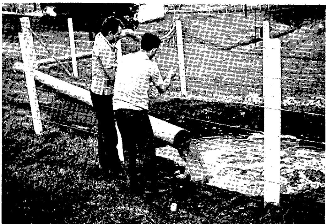
Instalação recém-construída de bombeamento de líquido da coluna barométrica para ser irrigado em valas de infiltração, também dentro do programa de controle da poluição causada pela Indústria da cana de açúcar.
