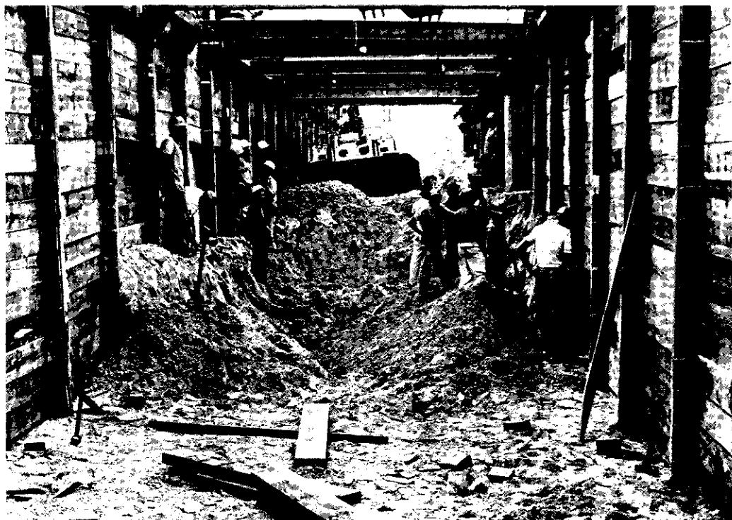
Detalhe da construção do 1.º trecho do Intercepto Oceânico, cuja secção de escoamento será de 2,70 m x 3,00 m.
