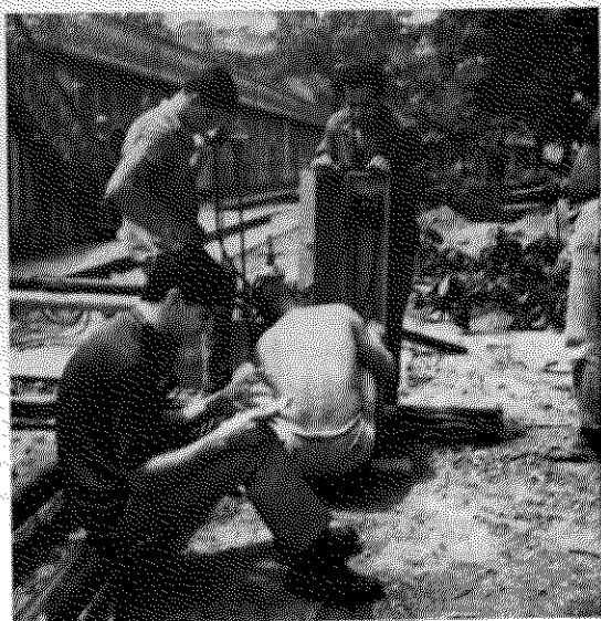
Foto 7 — Equipe de trabalho realizando as medidas no Tubo de Pitot.
