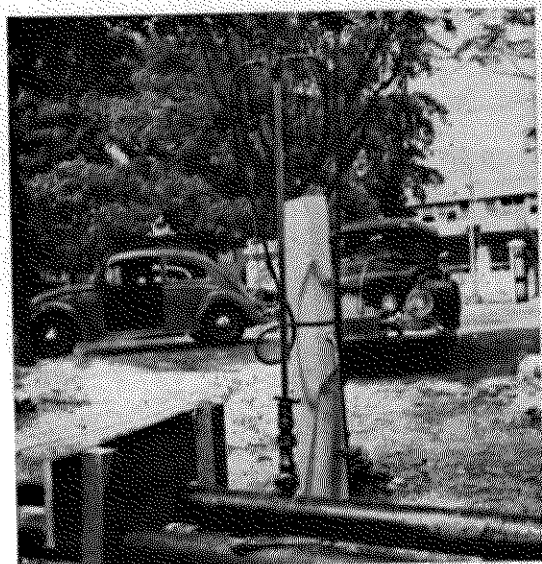
Foto 6 — Vê-se o Tubo de Pitot, empregado para medida das vazões.
