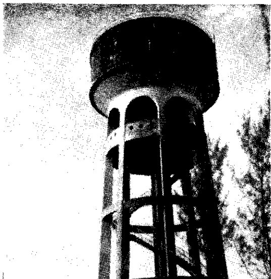
Foto 2 — Reservatório R5T do Garcia — 500 m 3
