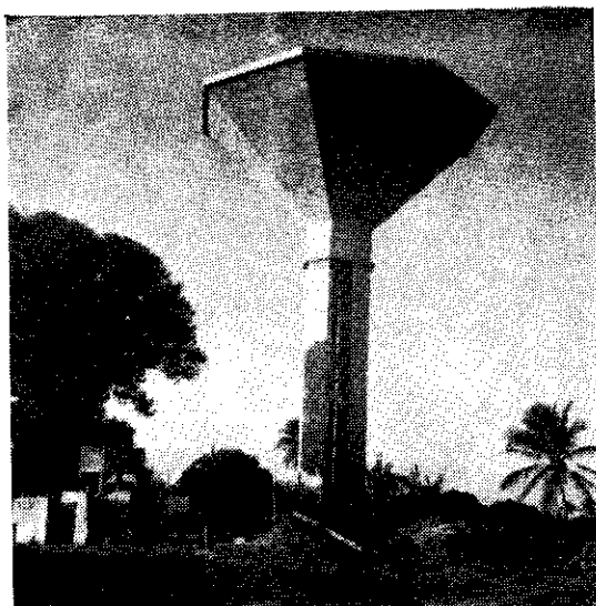
Foto 5 — Reservatório do Cabula — 500 m 3
