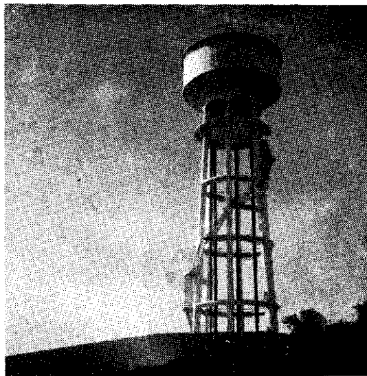
Foto 1 — Reservatório R6T de São Caetano — 280 m 3
