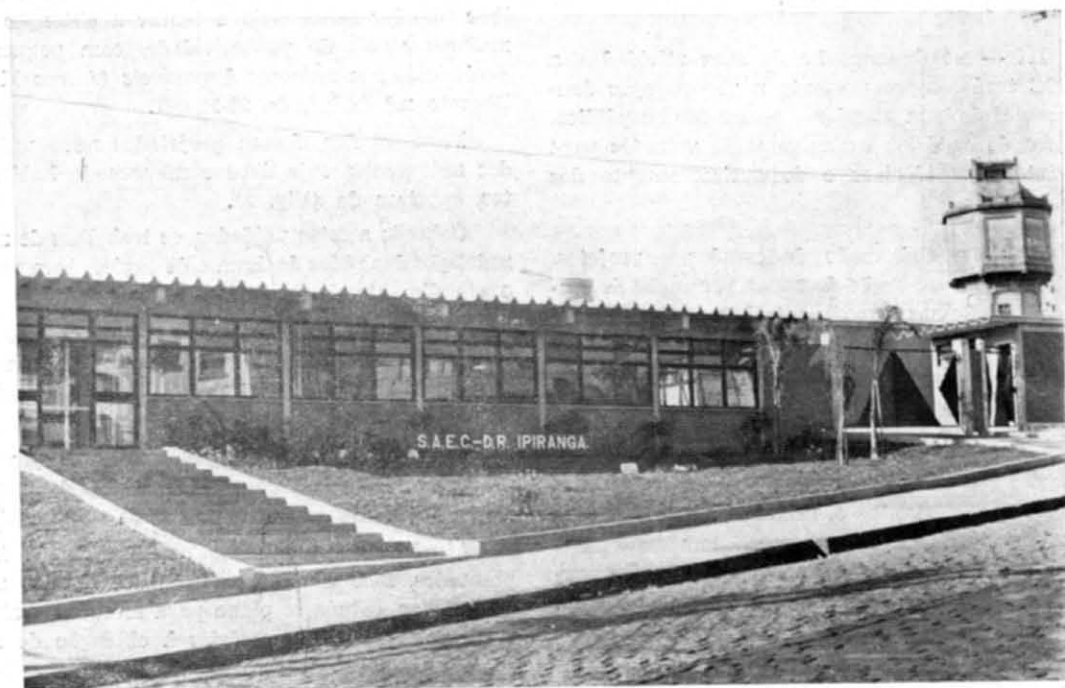
VISTA DAS INSTALAÇÕES DO DISTRITO REGIONAL DO IPIRANGA
