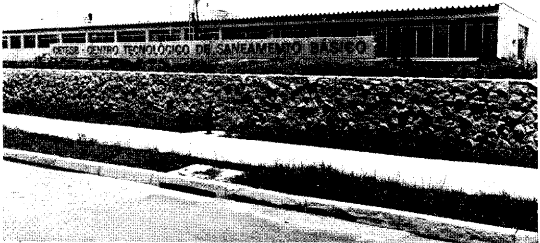
Aspecto parcial do edifício que abriga o Centro Tecnológico de Saneamento Básico-CETESB.
