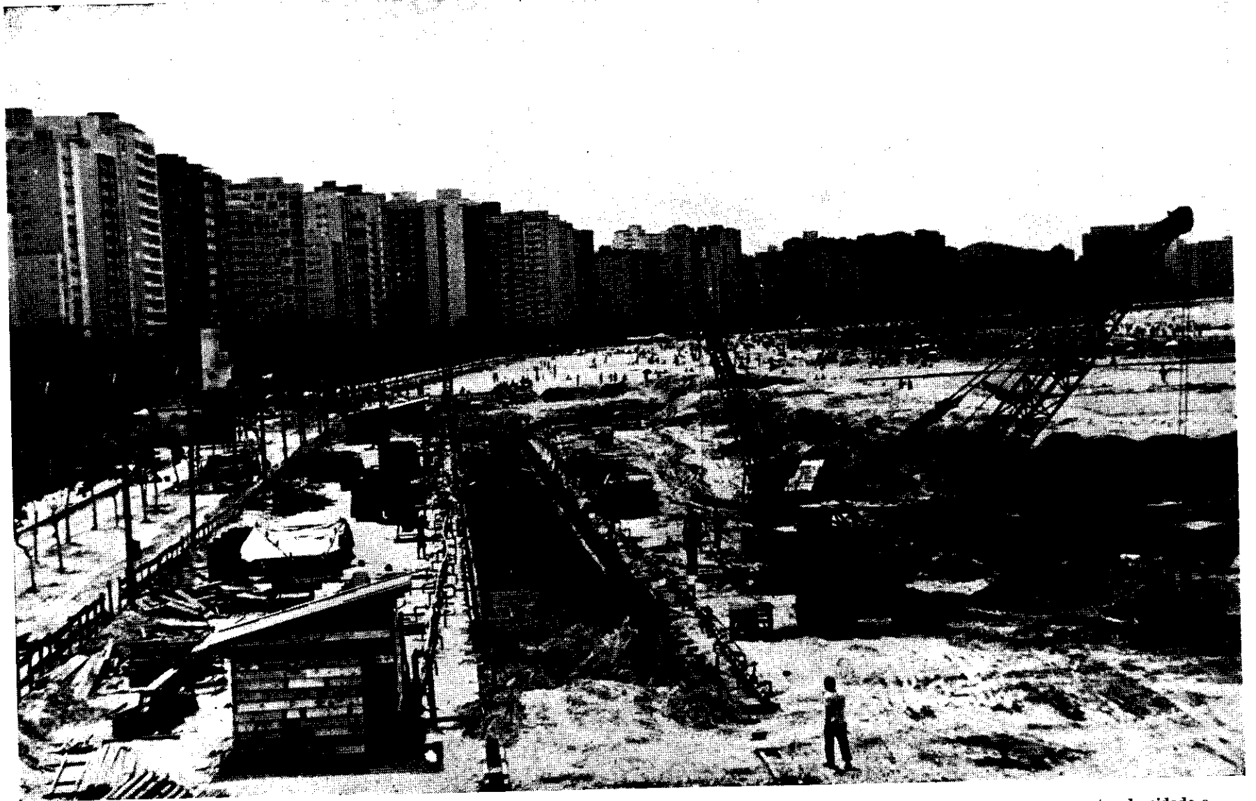
Interceptor Oceânico em construção na praia de Santos. Com uma extensão de 7,5 km e que permitirá receber todos os esgotos da cidade e ainda receber parte das águas dos canais de saneamento, evitando assim a contaminação das praias.
