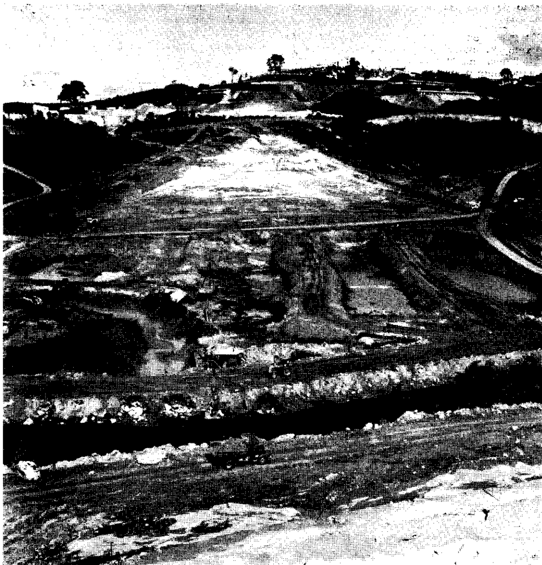
Obras de implantação da barragem do rio Atibainha. Além de permitir a regularização de vazão desse rio, permitirá fornecer substancial quantidade de água ao Sistema Cantareira.
