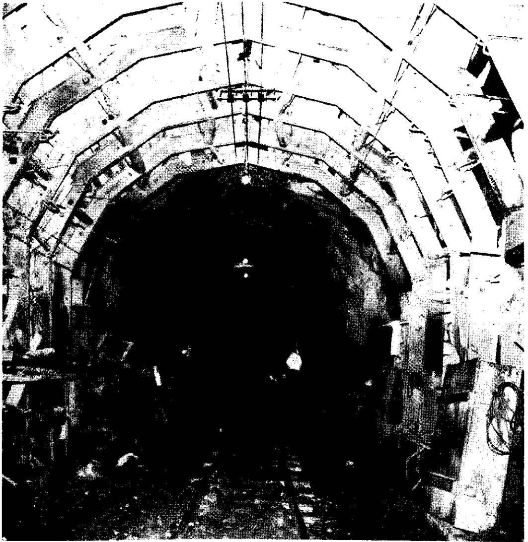
Abertura do túnel adutor de 1.100 m de comprimento destinada a conduzir a água para a estação elevatória subterrânea do Sistema Cantareira.
