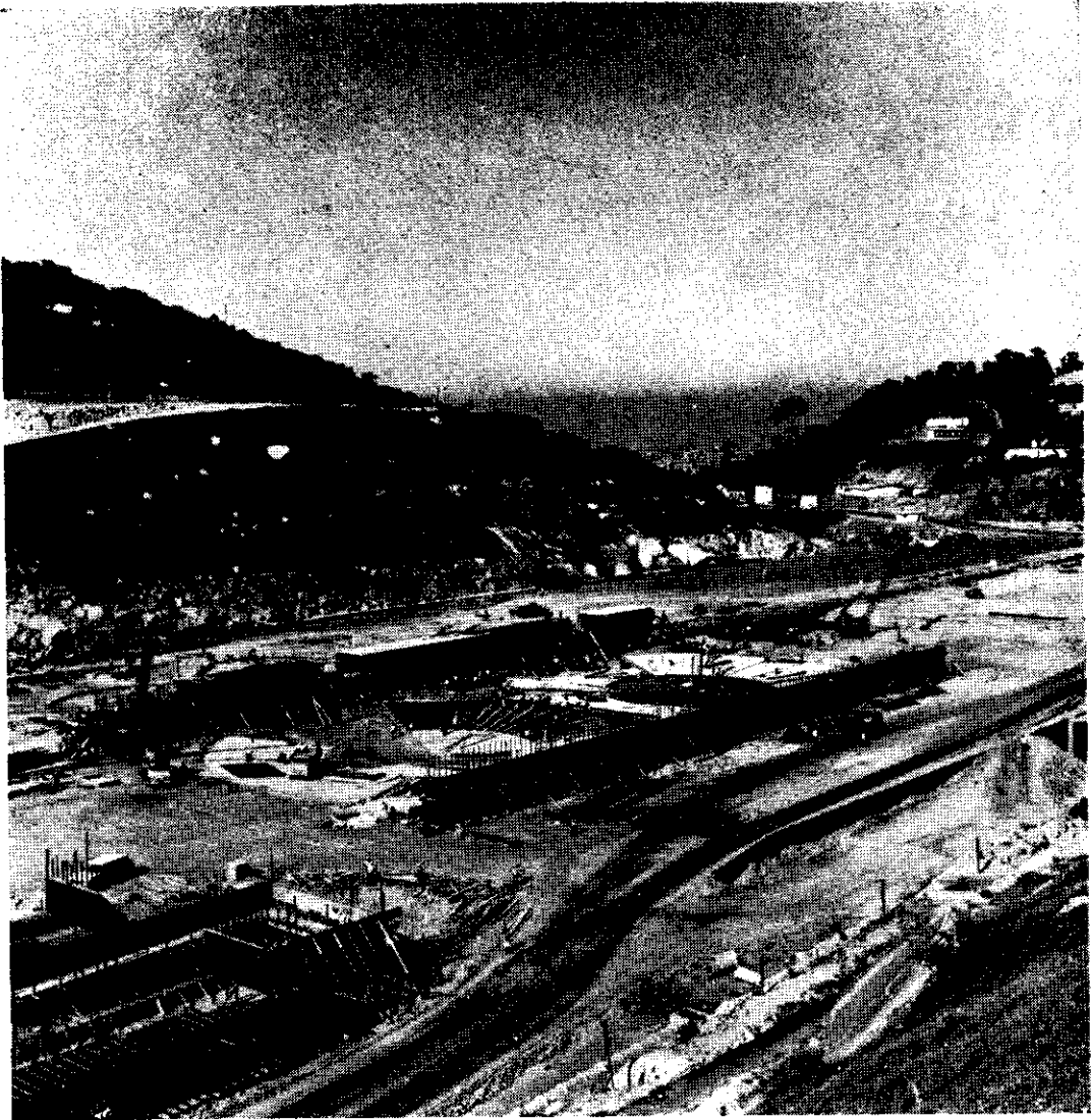
Obra da grande estação de tratamento do Sistema Cantareira com capacidade inicial para 11 m 3 /s e final para 33 m 3 /s. Será a 2. a estação do mundo.
