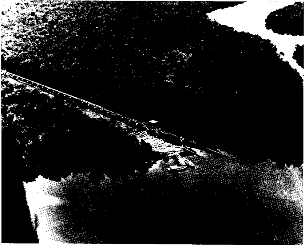
Obras da 2.ª Adutora do Jurubatuba (Guarujá) — fevereiro de 1969 Travessia sub-aquática do Rio Diana.
