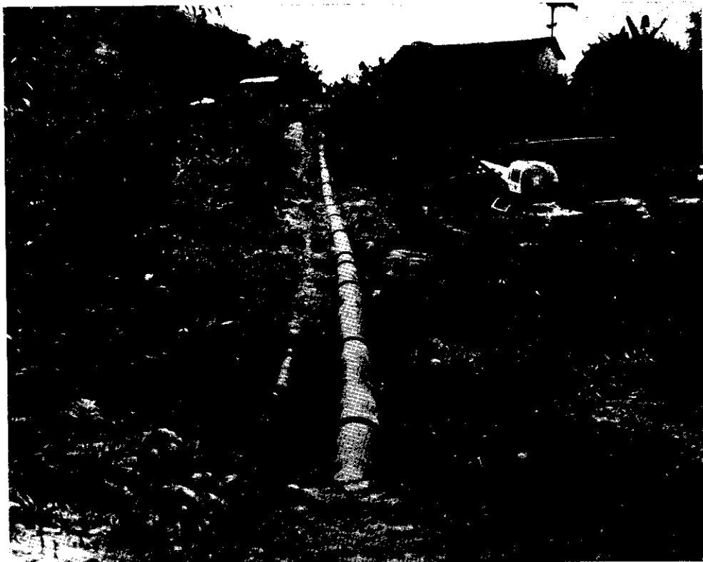
Obras da 2.ª Adutora do Jurubatuba (Guarujá) — fevereiro de 1969
