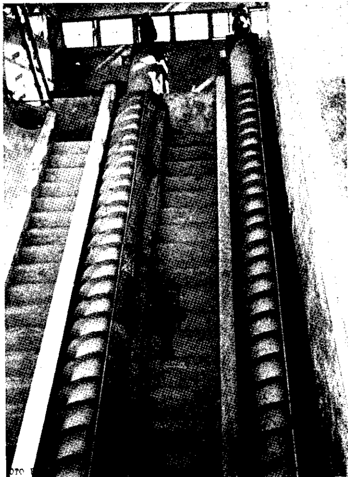
Estação Elevatória de Esgotos de Santa Maria. — Características de bombas; Sistema parafuso de Arquimedes. — Q = 40 \text{ l/seg.}
