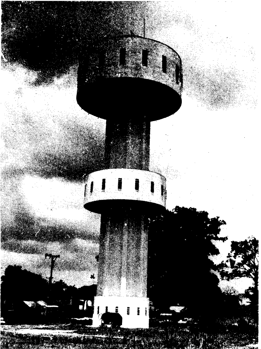
Reservatório Elevado do 5.º Setor (Duplo) — Belém.
