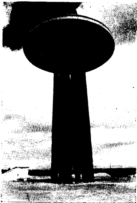
Reservatório de Apucarana, Paraná
