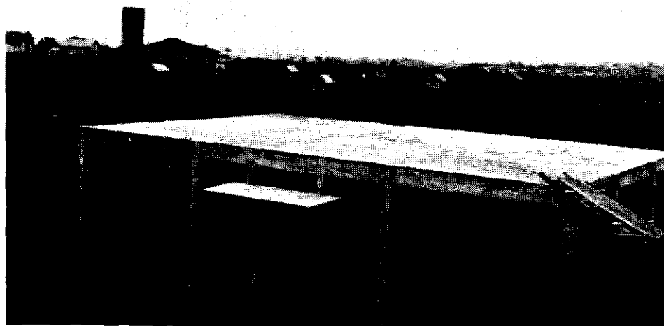
Fotog. 2 — Casa de Manobras — Estrutura de Concreto Armado
