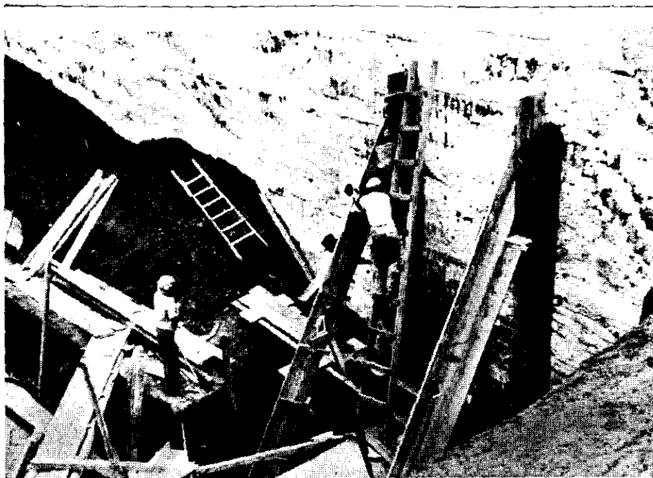
Fotog. 3 — Contraforte Triangular — Detalhes da construção (ala direita)
