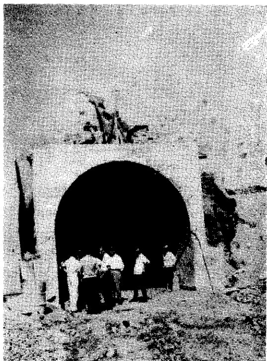
Tunel maior com 4750 m; partes das obras do sistema intermediário. Face de montante.
