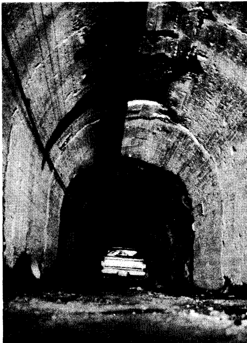
Vista interna do túnel menor que terá 826 m. de comprimento. (Obras intermediárias, 1. a parte).
