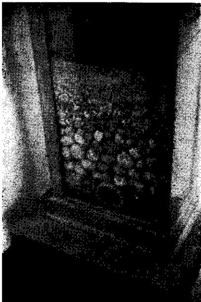
Foto 5 — Colorado Springs, Colorado (20/6/66). Como era o fundo dos filtros rápidos para tratamento da água.
