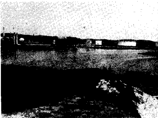
Fig. 7 — REPRESA VELHA DA REFINARIA DE CAPUAVA — Em funcionamento desde 1954. Capacidade 500.000 m 3 . Comprimento maior 470 m. Profundidade máxima 15 metros.
