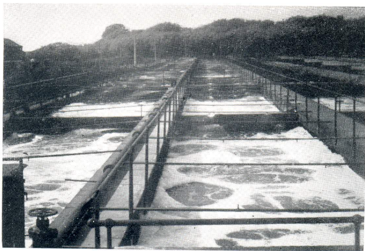
Fig. 8 — MANCHESTER, IN- GLATERRA — ETE Davyhulme — Lodos ativados com os asper- sores para quebrar a espuma devida a detergentes.
