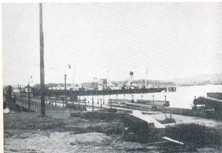
Fig. 21 — LONDRES, Northern Outfall Works — Embarque de lodos digeridos para lançamento no mar.
