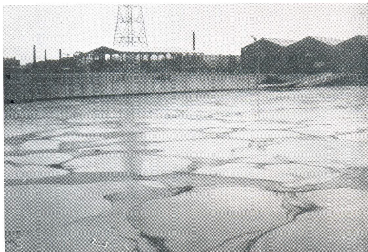
Fig. 19 — LONDRES, Northern Outfall Works — Secagem de lodo ao ar livre (lodo parcialmente digerido nos digestores).
