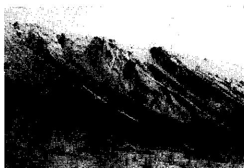
Fig. 3 — Estrada de Ferro Sorocabana, erosão dos taludes e destruição dos canais de drenagem, km 61/63.
