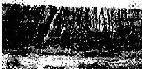
Fig. 2 — Estrada de Ferro Sorocabana, erosão no aterro km 61/63 aproximadamente.
