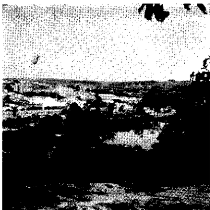
FIG. 10 Lagoa de estabilização dos resíduos de uma fábrica de papel.
