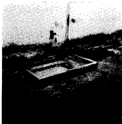
Fig. 1 Tanque retentor de gordura.
