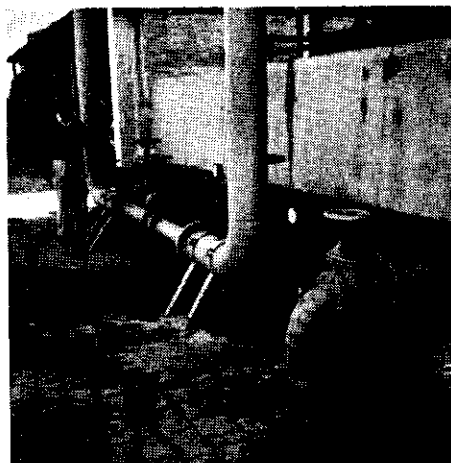
FIG. 5 Tubulações e válvulas de expansão em um tanque de flotação geminado.
