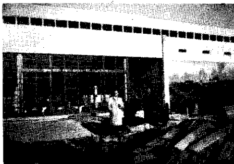
FIG. 6 — Vista da casa de bombas e controle.
