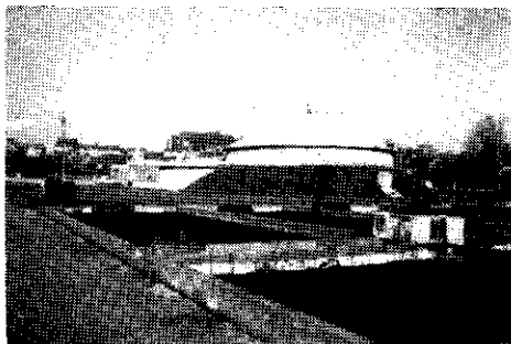
FIG. 6 — Vista geral da estação de tratamento de esgotos de D'Alençon
