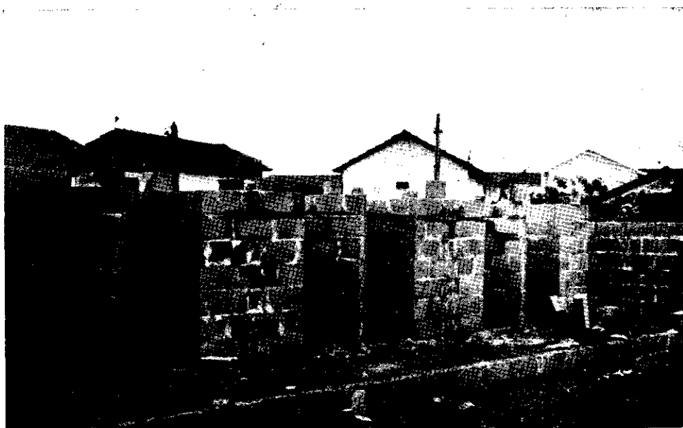
Fig 1 — Aspecto da construção dos sanitários.
