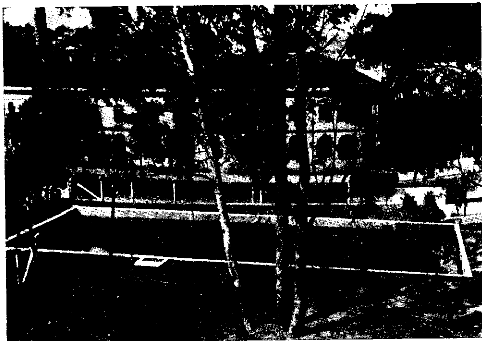
FIG. 4 — Tanque de retenção, decantação, homogeneização e lançamento em vazão constante, com capacidade de 510 000 litros. Ao fundo, o Curtume Cantúcio S. A.
