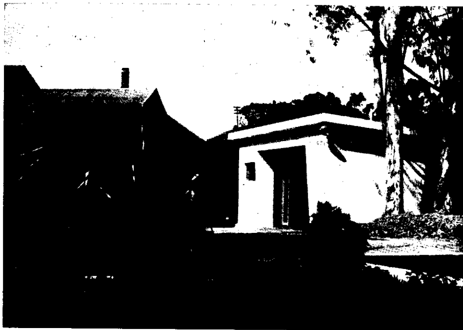
FIG. 2 — Casa de bombas. Árvores e plantas ornamentais ocupam os espaços vagos.
