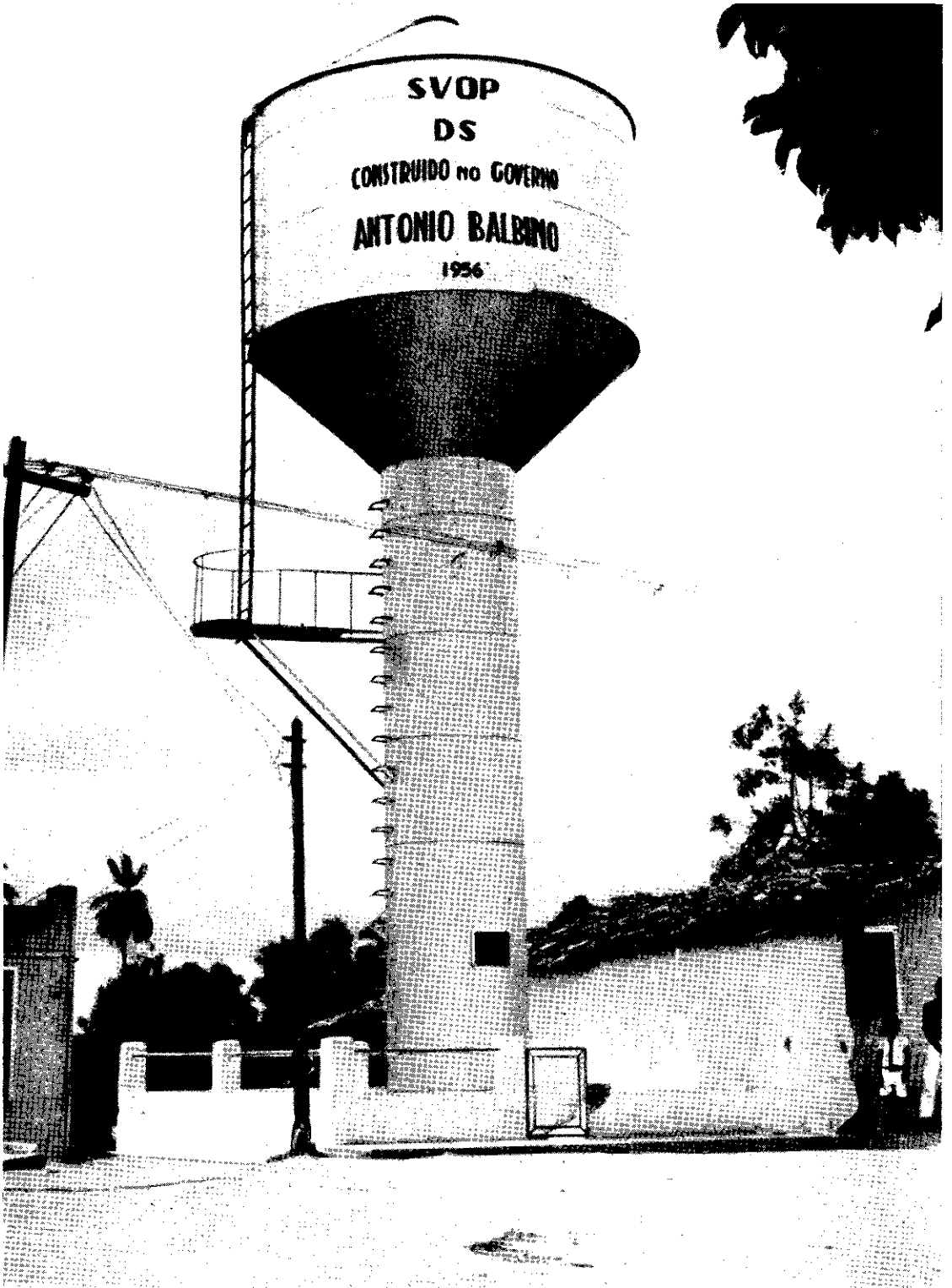
Torre de aço executada numa pequena cidade do interior da Bahia. Tem o mérito de ter sido construída inteiramente com os recursos locais.
