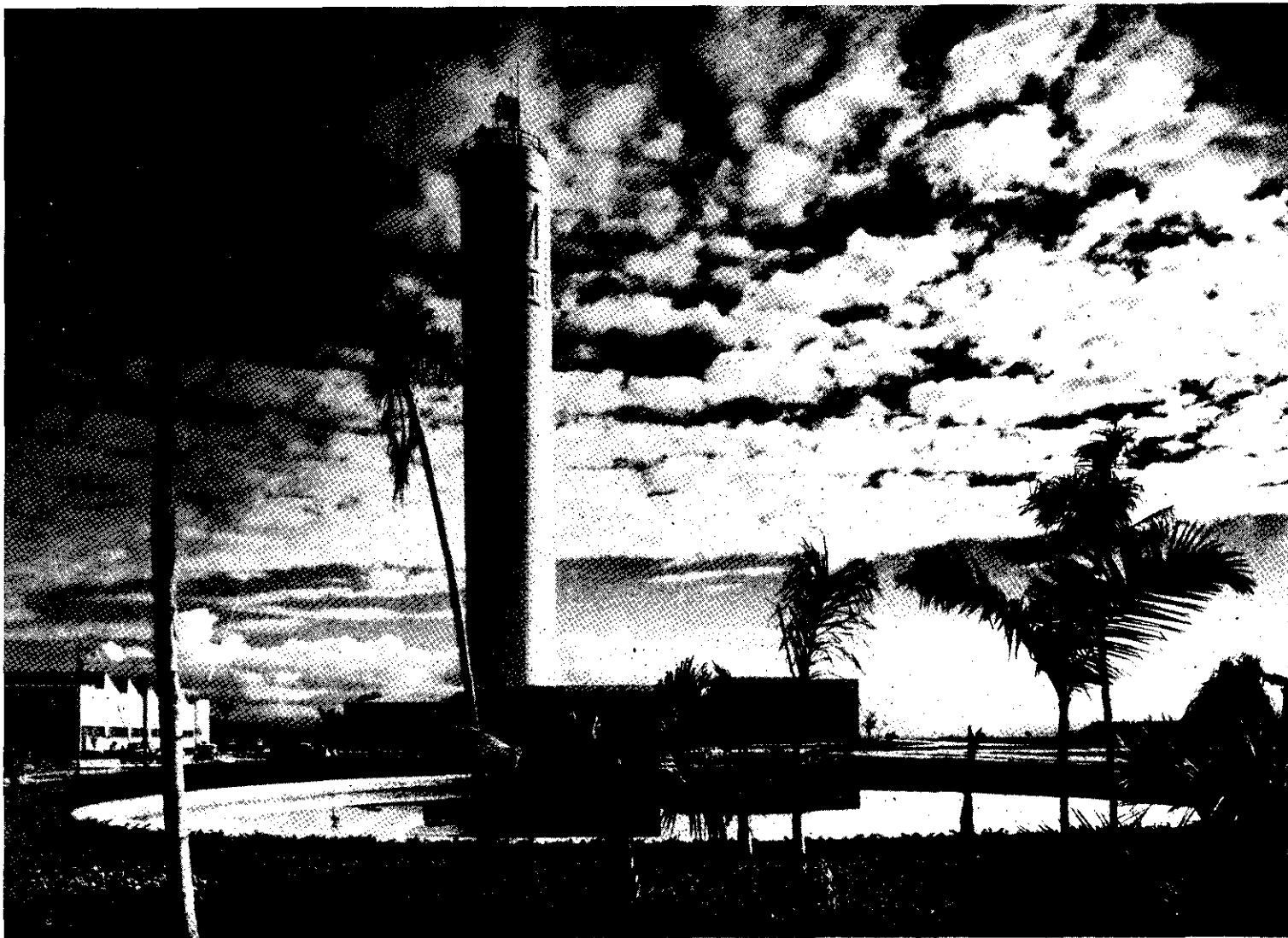
Reservatórios da novo conjunto industrial da General Motors do Brasil, em São José dos Campos. O reservatório inferior tem capacidade de 3.800 m 3 . A Torre, com 43 m de altura, está dividida em três secções: 500 m 3 para água potável, 500 m 3 para água
