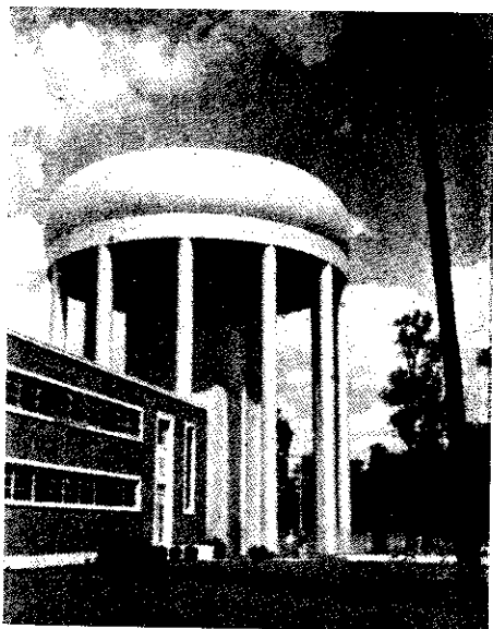
Torre de aço, de estilo simples e aprazível, com 3.800 m 3 de capacidade. (Serviço de Água de Royal Oak, Michigan).
