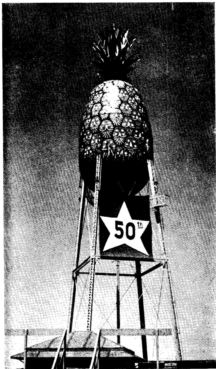
Curiosa Torre executada em um bairro de Honolulu (Hawaii), em 1927. Capacidade: 380 m 3 .
