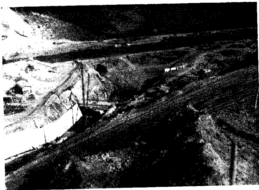
As obras do Reservatório de Santa Branca, da qual vemos um aspecto no clichê, levadas a efeito pela Rio Light S.A. — Serviços de Eletricidade e Carris, encontram-se em sua fase final. O atêrro está praticamente pronto e permitirá, na próxima estação chuvosa, sejam armazenados os excessos de água que se verificam no alto Paraíba nessa época do ano. Esse empreendimento, além de permitir o maior aproveitamento da capacidade geradora das usinas Fontes e Nilo Peçanha, em Ribeirão das Lages, trará grandes benefícios à região em que está localizado, uma vez que novas estradas e pontes de elevado padrão técnico foram construídas para substituir as que existiam na área inundada.
