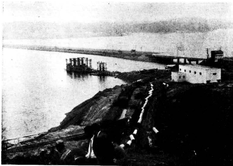
FIG. 10 — Execução da linha de recalque (22-11-57).
