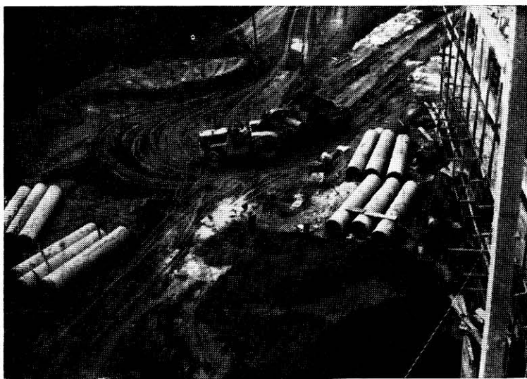
FIG. 11 — Execução da linha de gravidade e da via de acesso junto à Estação de Tratamento (2-12-57).
