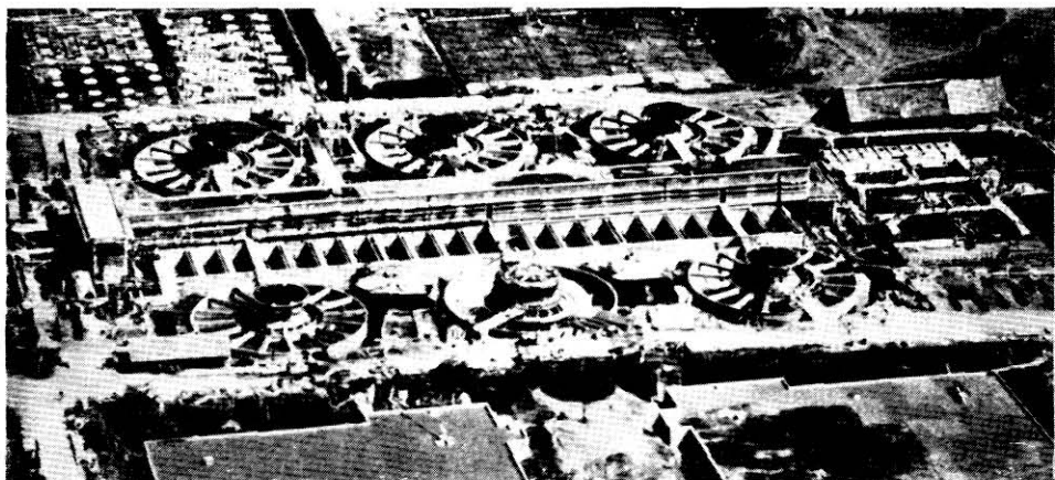
Fotografia tomada durante a construção da Estação de Tratamento de Águas de Djakarta — Java
