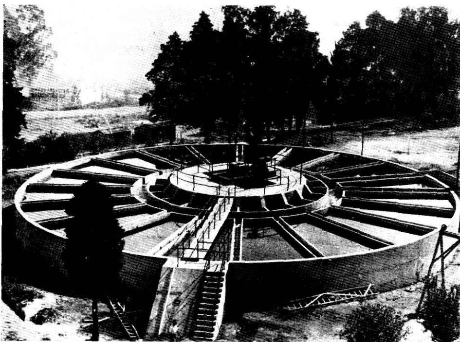
Accelerator com 33 m de diâmetro — Capacidade total 86 MLD Estação de Tratamento de Santo Amaro — Abastecimento da cidade de S. Paulo
