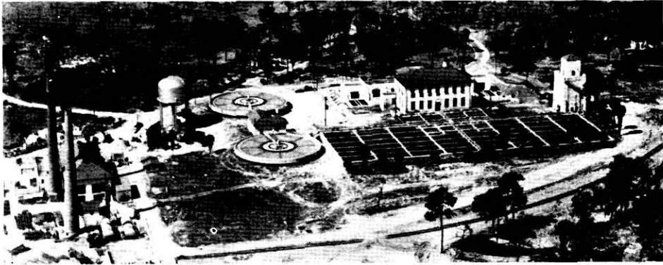
Estação de Tratamento de Águas de Tampa — Florida 2 Acelerators capacidade 114 MLD
