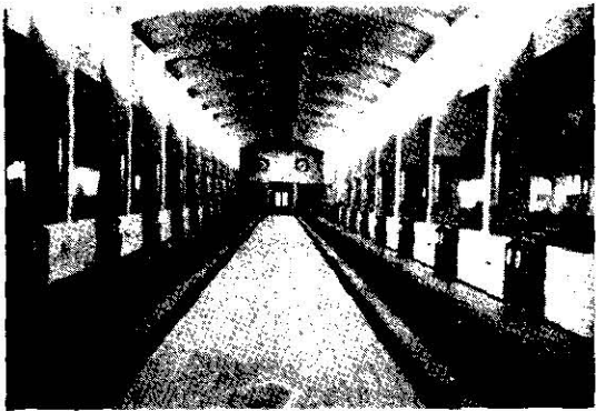
19 — Galeria de filtros
