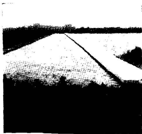
13 — Tanque de Decantação
