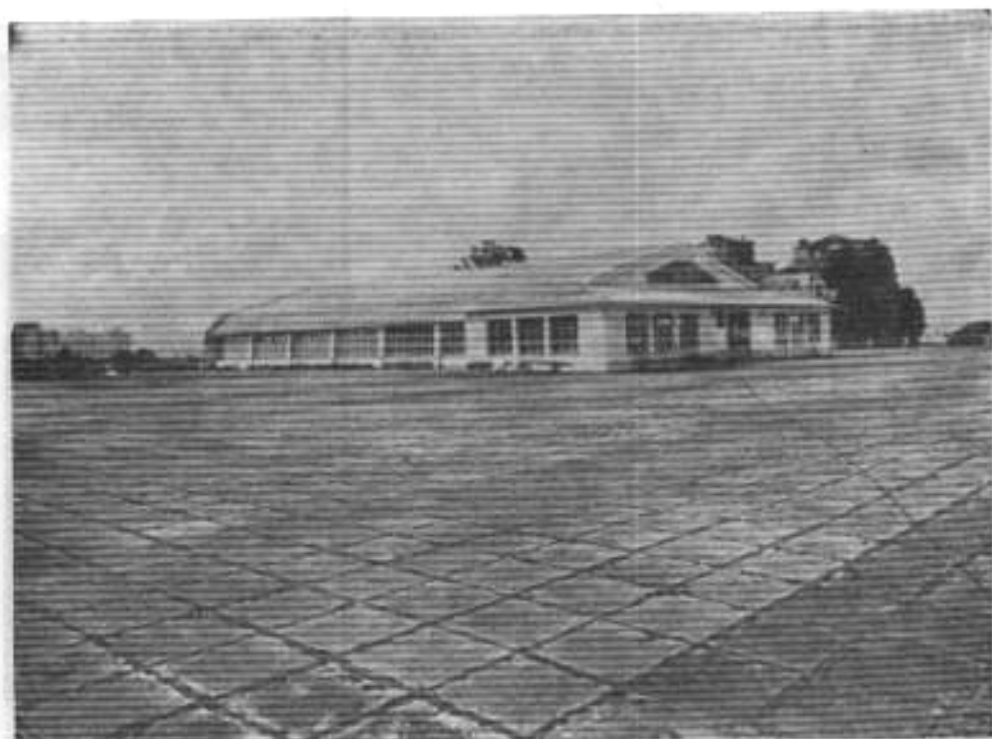
RESERVATÓRIO NOVO DA CONSOLAÇÃO: Capacidade de 42 milhões de litros. Vista superior da Casa de Manobras. Receberá até 90 milhões de litros/dia das novas adutoras de Santo Amaro. A Subadutora entre este reservatório e o de Vila Américo já está concluída.
