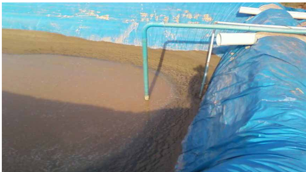
Figura 1: Tanque de armazenamento de efluente para reutilização na irrigação
