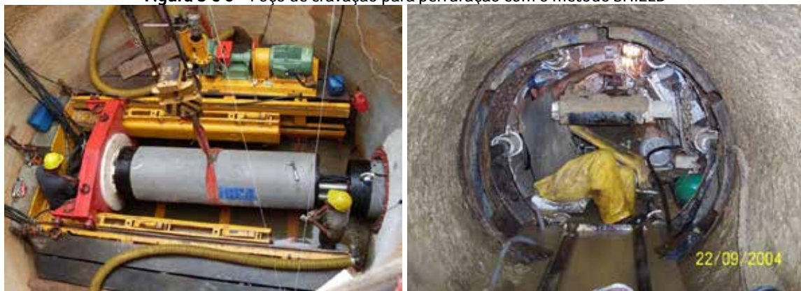
Figura 5 e 6 – Poço de cravação para perfuração com o método SHIELD
