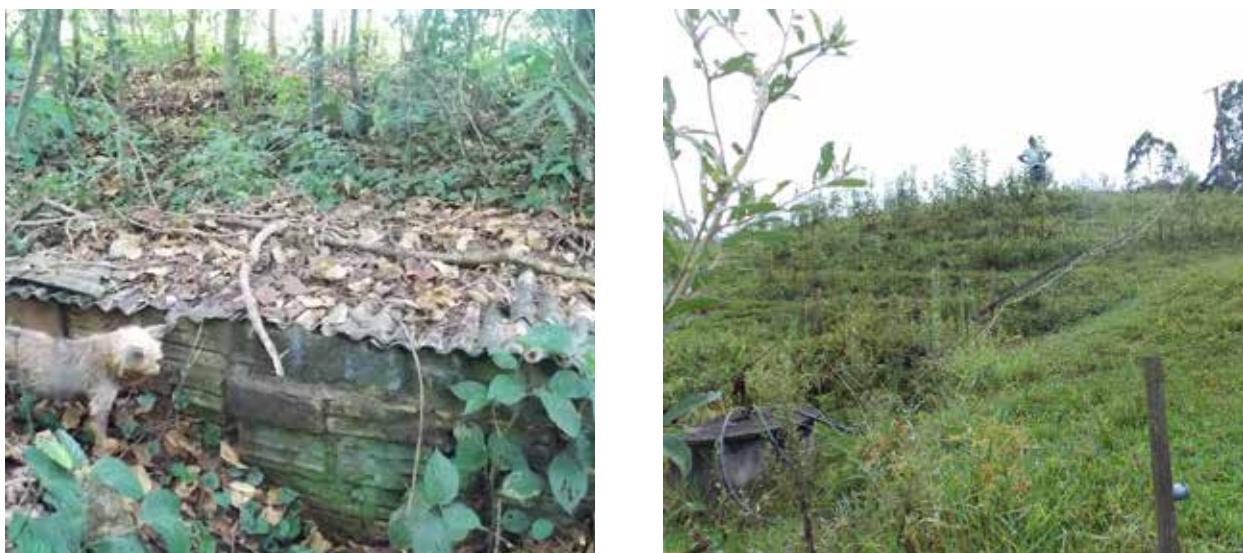
Figura 5 - Captação em nascente (esquerda) e captação em poço (direita) nas comunidades visitadas. Fonte: Acervo fotográfico PNSR (fevereiro de 2016).
