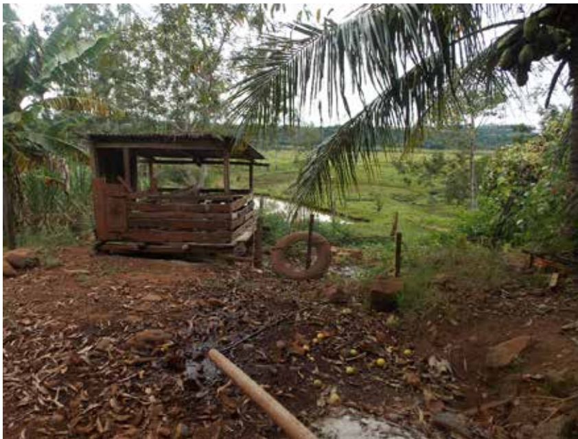
Figura 6 – Escoamento de águas cinzas pelo terreno de uma das casas visitadas. Fonte: Acervo fotográfico PNSR (fevereiro de 2016).
