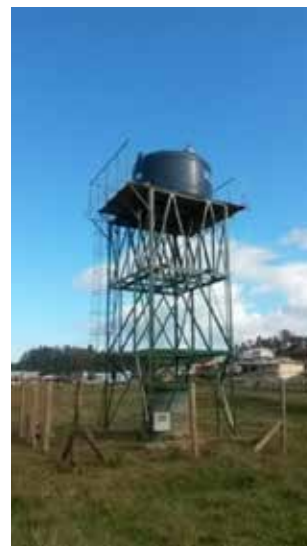
Figura 2: Foto do poço de FM e o reservatório elevado de armazenamento de água.
