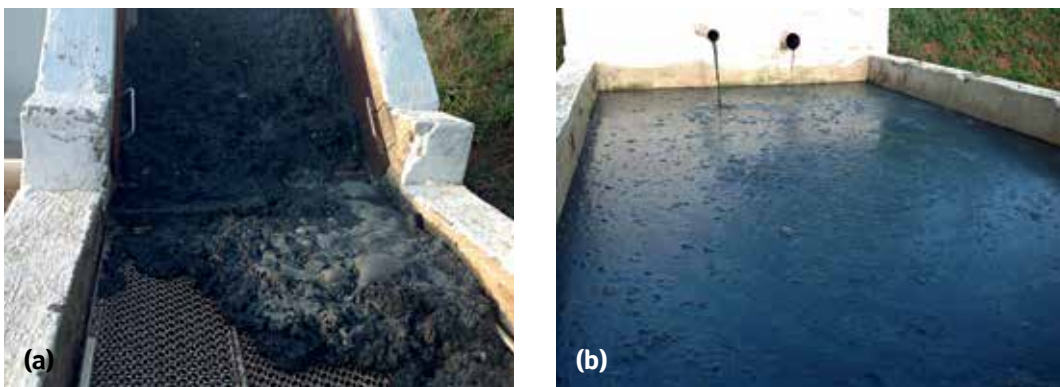
Figura 18 – a) Fração grosseira de espuma retida em unidade de peneiramento; b) fração sobrenadante de espuma enviada para leito de secagem.
