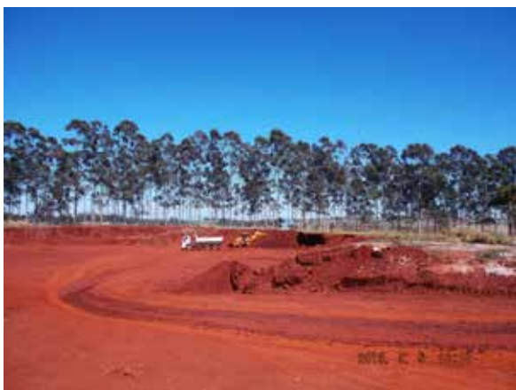
Figura 1 - Construção do aterro de RCC classe A e resíduos inertes em 2013.
