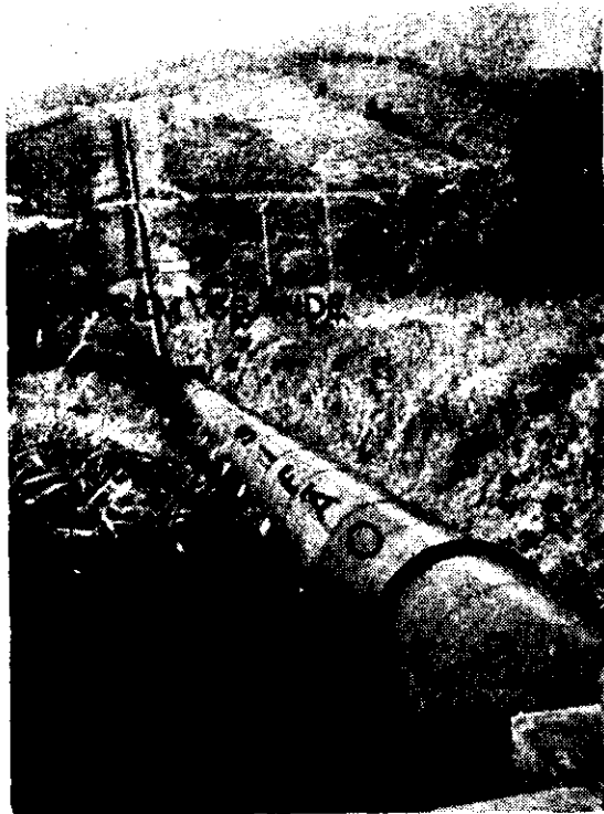
Caixa de jusante do Sifão 19 — “Vargem Grande” — da Adu- tôra do Rio Claro
