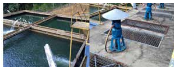
Figura 4 – ETA1 de Pomerode, a mais antiga com filtração lenta no estado.
