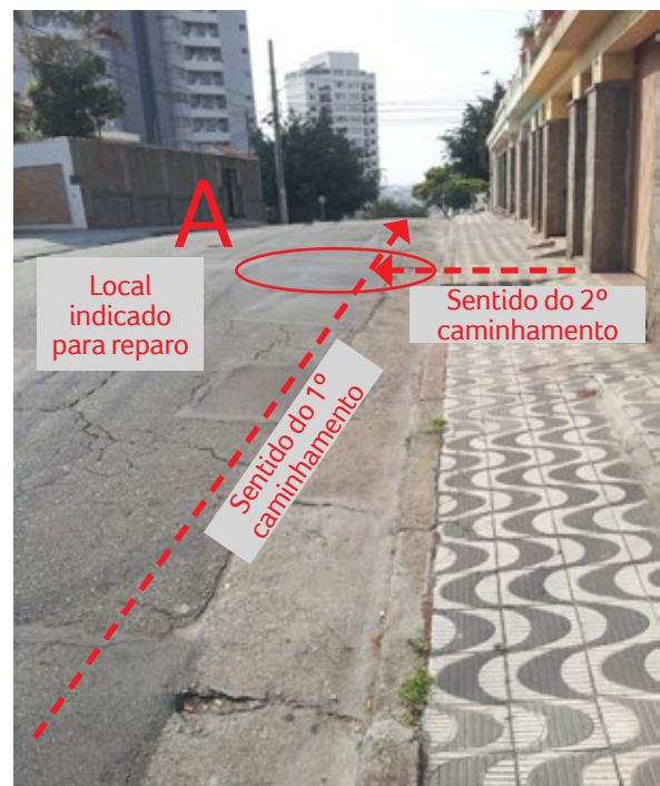
Figura 4 – Fotografia do local onde foram realizados os caminhamentos com a PDPV e onde foi marcado com tinta para reparo do vazamento.
