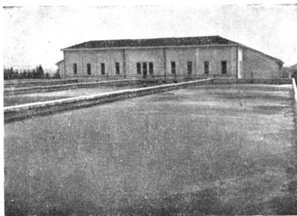
Uma das bacias de decantação com a superficie da agua coberta pelos flocos sobrenadantes.
