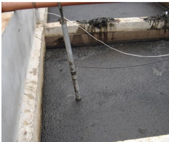
Figura 12 – Remoção do lodo dos tanques
