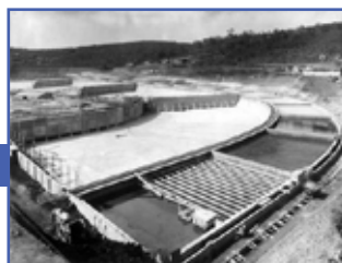
Construção da Estação de Tratamento do Sistema Alto Cotia, cujas obras foram iniciadas em 1914. S/d, Acervo Memória Sabesp
