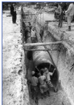
Obras do Sistema Alto Cotia, na Avenida Brasil, em São Paulo (SP). Início do século XX, Acervo Memória Sabesp
