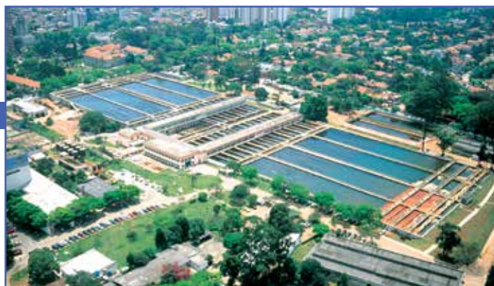
Estação de Tratamento de Água Alto da Boa Vista, Sistema Guarapiranga. S.d. Acervo Memória Sabesp
