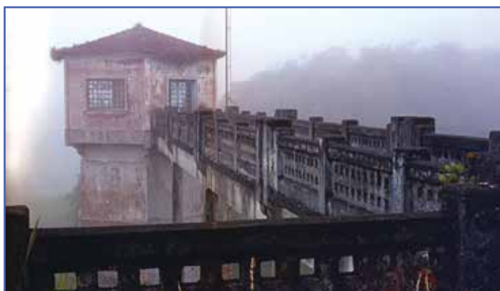
Torre de captação de água do Poço Preto, pertencente à Adutora Rio Claro, localizada a 86 quilômetros de São Paulo. S.d. Acervo Memória Sabesp
