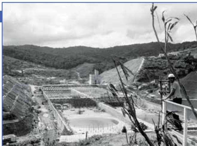
Construção da Estação de Tratamento de Água do Guarapé, obra integrante do Sistema Cantareira. S/d, Acervo Sabesp
