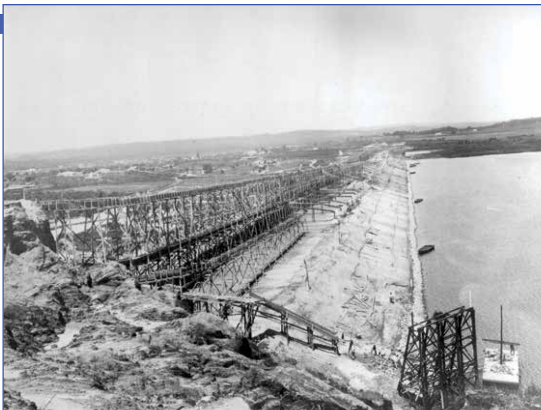
Construção da represa Guarapiranga, que posteriormente se tornará importante manancial para abastecimento de água em São Paulo. 1906, Acervo Fundação Energia e Saneamento
