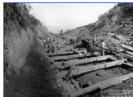
Obras de construção do aqueduto 3, pertencente ao Sistema Rio Claro. Outubro de 1933, Acervo Sabesp
