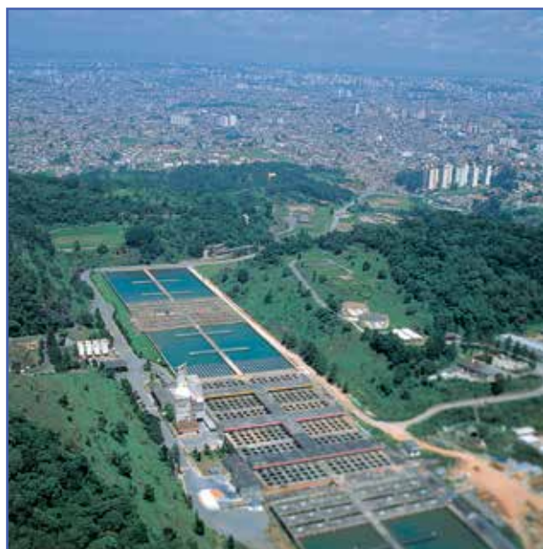
Estação de Tratamento de Água do Guarapiranga, obra integrante do Sistema Cantareira, inaugurado em 1974. S.d. Acervo Memória Sabesp
