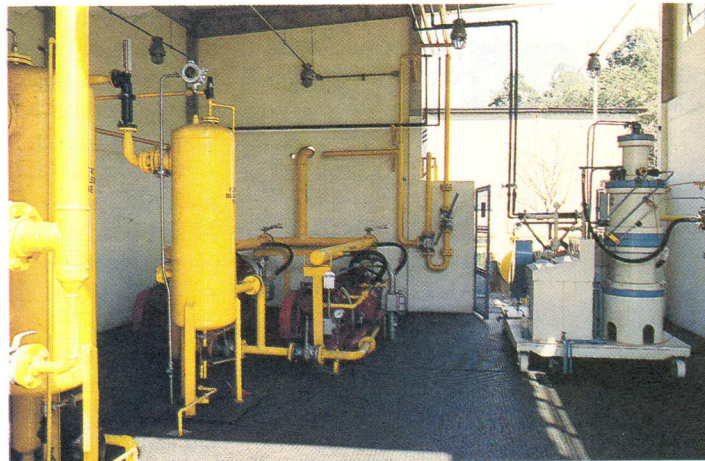
Baseada nos resultados de uma estação-piloto, a Sabesp construiu e opera uma usina de purificação e compressão de metano.
