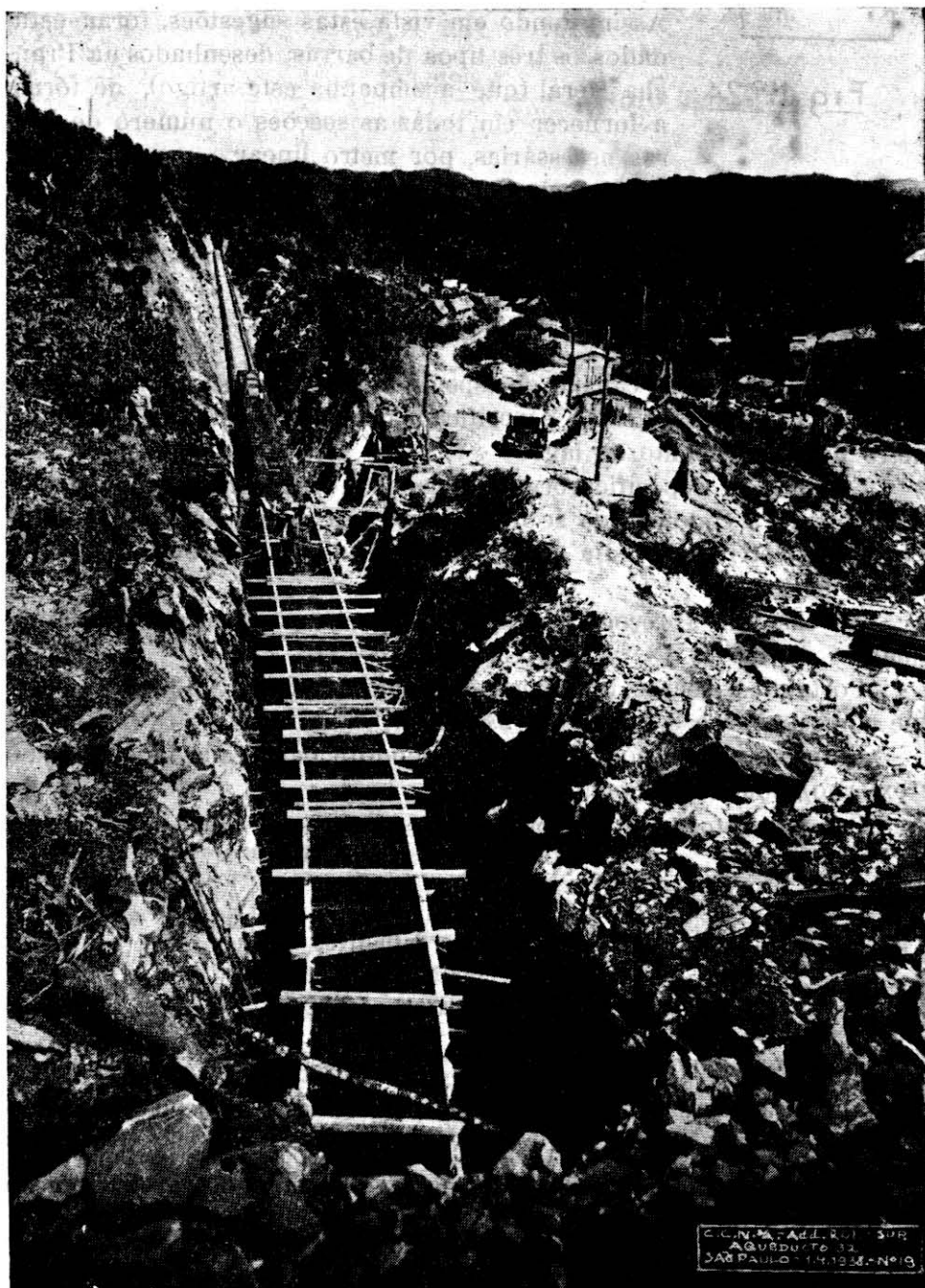
Construção do Aqueduto da Adutora Superior — Colocação das Armaduras
