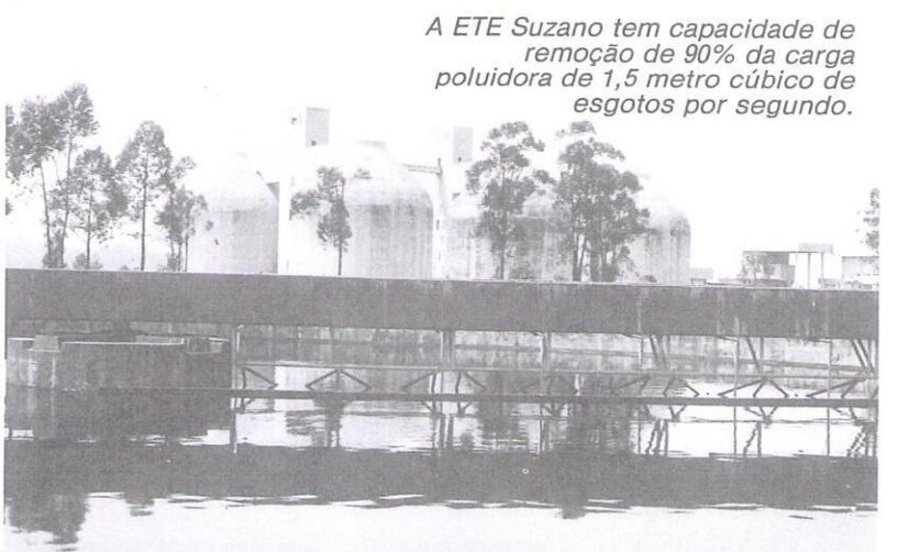
*A ETE Suzano tem capacidade de remoção de 90% da carga poluidora de 1,5 metro cúbico de esgotos por segundo.*
