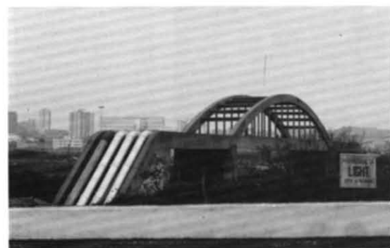
Adutora sobre o rio Pinheiros.
